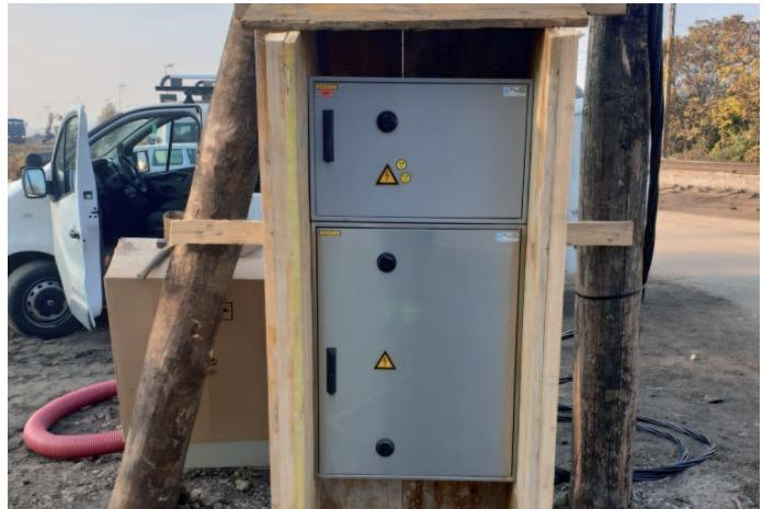
Oprema in certificiranje elektro omar za začasne priključke na gradbiščih (gradbene omarje)
