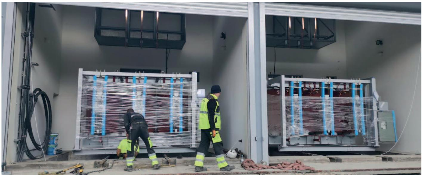
Montaža zbiralnic in elektro opreme v elektro napajalni postaji (ENP) za napajanje elektrificiranega železniškega omrežja
