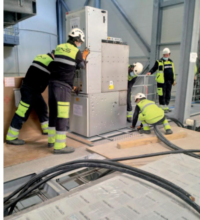
Montaža elektroenergetskega napajanja v industrijskem objektu na Nizozemskem
