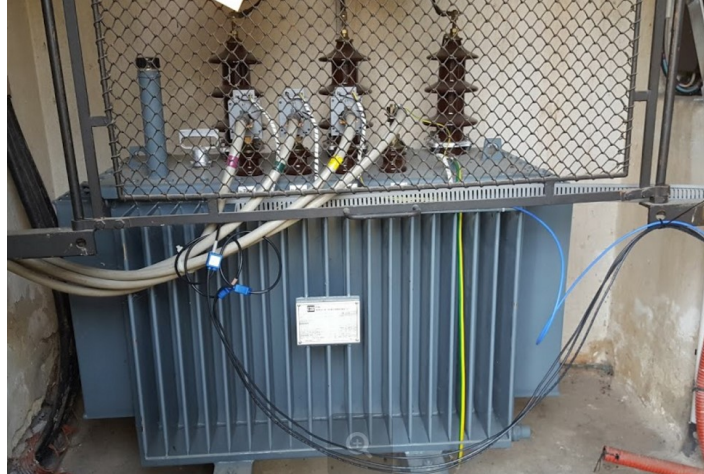
Slika 10: Priključitev merilnih členov na transformator
