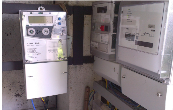
Slika 11. Vzporedno merjenje pretokov energije z obstoječim števcem električne energije
